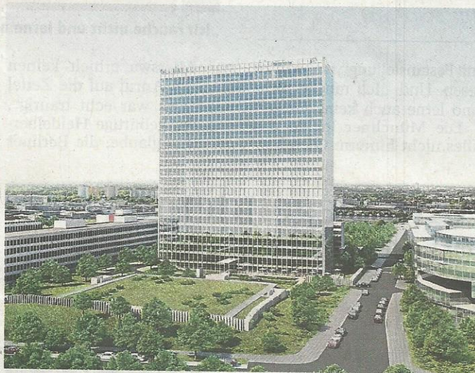
Wohnungen statt Büros: Das frühere Siemens-Hochhaus an der Baierbrunner Straße soll umgebaut werden. HAUPT IMMOBILIEN
